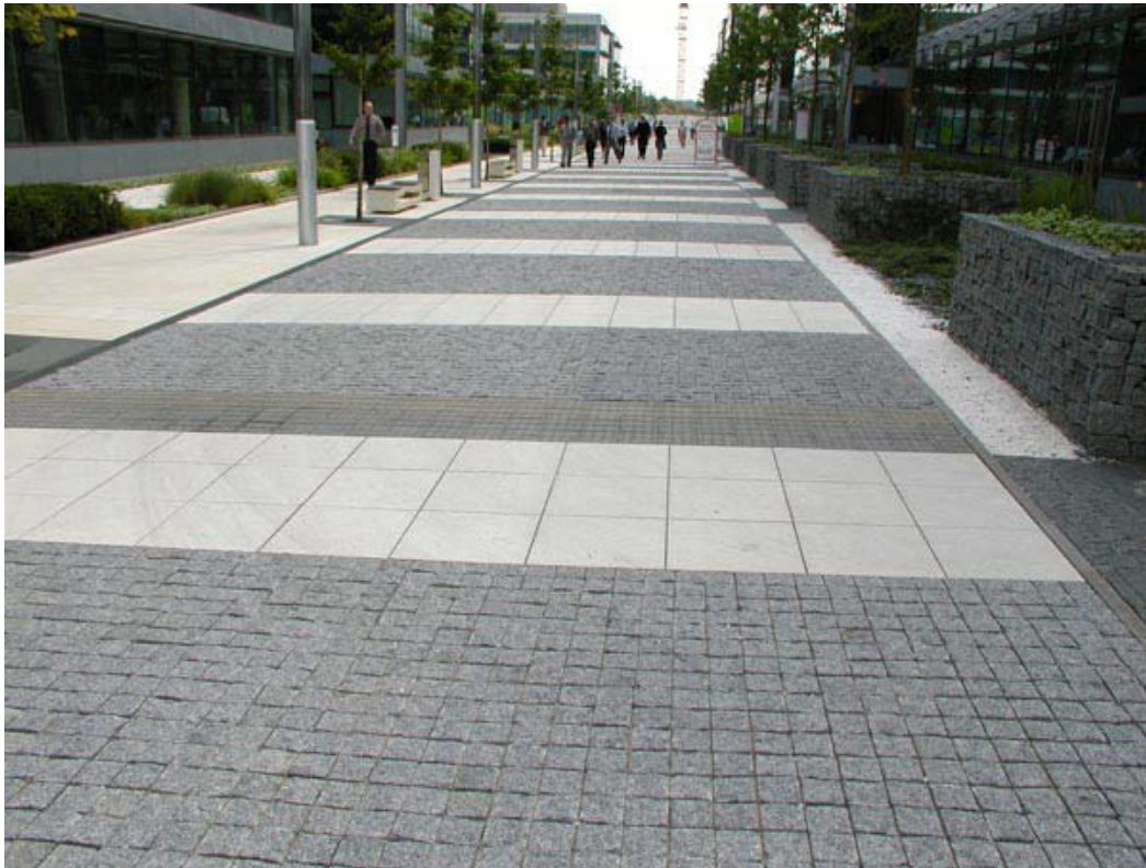
Inspirační fotografie - zpevněné povrchy (náměstí ,chodníky...)
