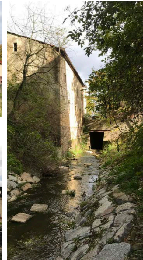
areál parních mlýnů - pohled od potoka
