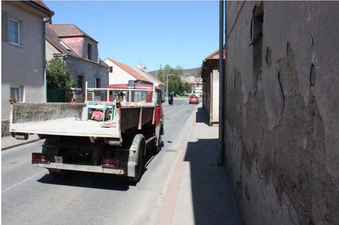
obr. 1 Stávající stav ulice Palackého. Úzký profil ulice neumožňuje bezpečný pohyb chodců, většinu ze šířky ulice zabírá vozovka.
