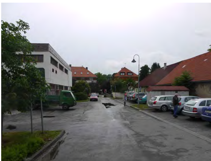
obr. 17 Boční část s parkováním, přístupná od ulice Palackého – veřejný prostor využívaný jen automobily, i když se jedná o centrální část města prostor je zanedbaný a nehezky.
