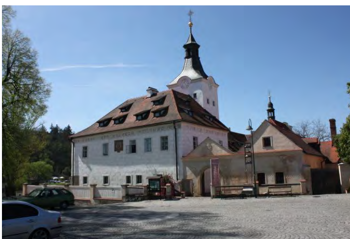
obr. 13 Raně barokní Dobřichovický zámek se nachází v místě tvrze doložené k roku 1420, která vznikla opodál křižovnického hospodářského dvora. S ohledem na její polohu ve vsi, nelze vyloučit, že tvrz vznikla až v době, kdy jádro vsi již existovalo.
