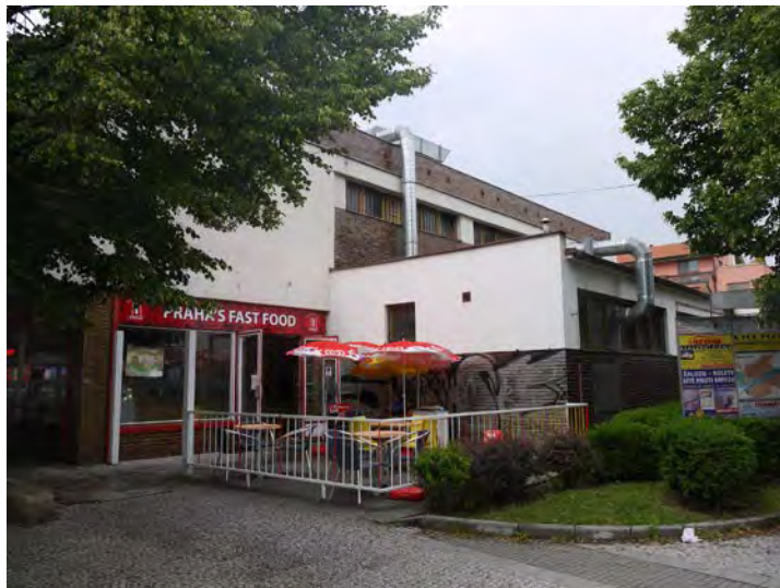
obr. 14 Pohled na Jednotu z ulice 5. května – nevhodně vysázené keře brání volnému pohybu, parter je nekultivovaný a návštěvníka odrazuje.
