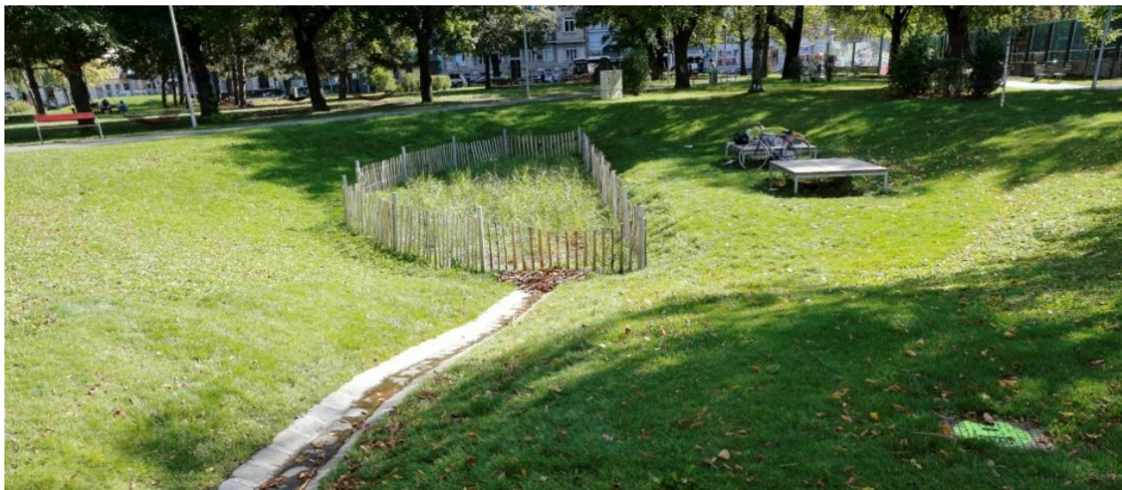
Příklad řešení vsakovacího průlehu:
